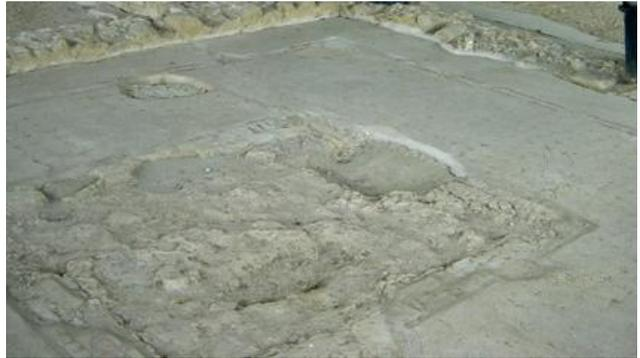
4. Ricostruzione di parte di muratura (lati nord e nord-est) per chiusura pavimentazione, ricostruzione di alcune parti e sigillatura per evitare le infiltrazioni di acqua nella zona dei mosaici.
